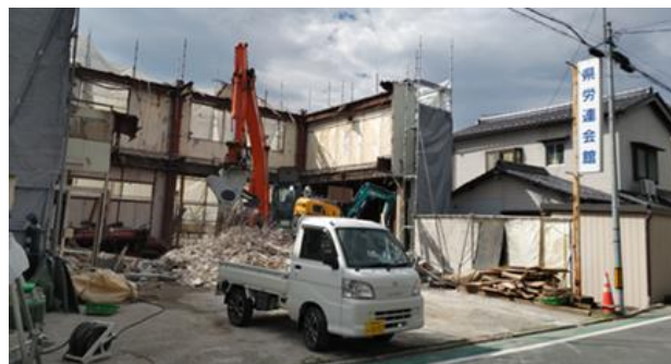
解体中の様子
