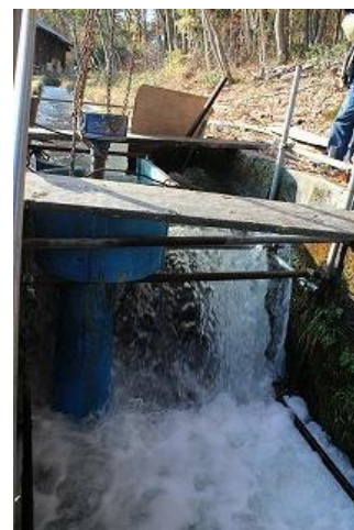
（駒沢小水力発電所）
